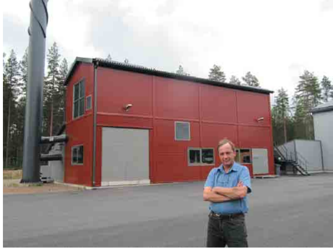
Karvian Lämpö Oy on nykyaikainen 1,5 MW:n aluelämpölaitos.
